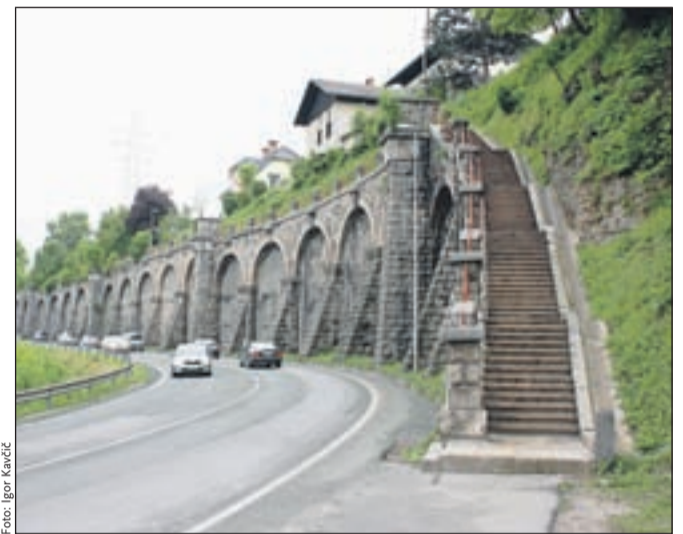
Gaštejski klanec s kamnitim opornim zidom še danes predstavlja prepoznaven arhitektonski element mesta Kranja.
