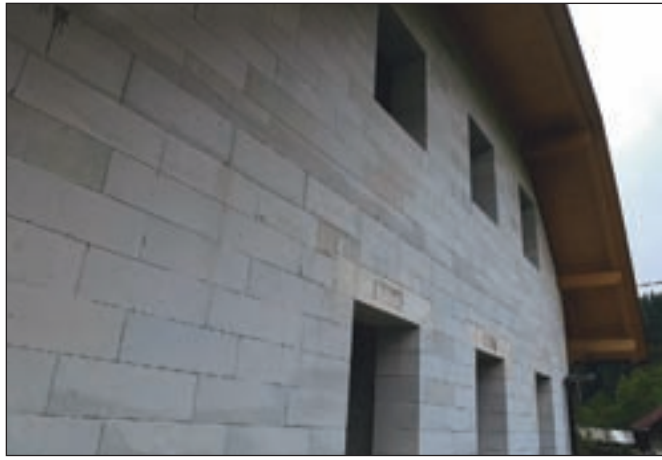
Natančnost zidave, tanke fuge, lažja vgradnja inštalacijskih vodov in stavbnega pohištva so le nekatere prednosti gradnje s sistemi Ytong.
