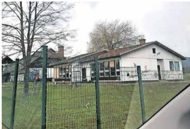
Vrtec Biba pred obnovo ... / Foto: MOK
