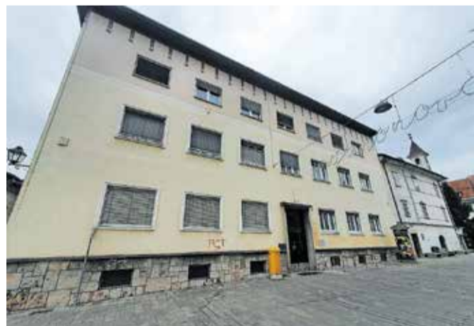
Kovačnica pred obnovo / Foto: MOK
