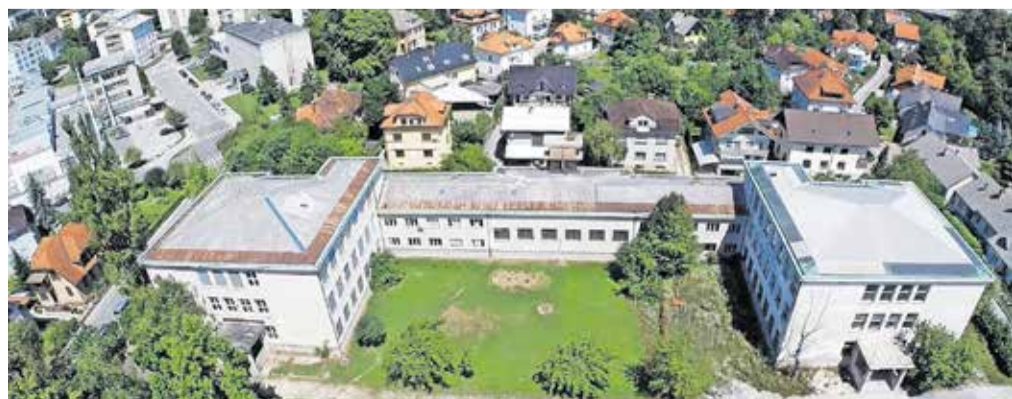
PŠ Center pred obnovo ... / Foto: MOK
