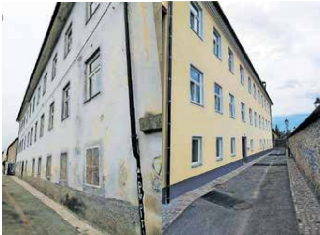
Objekt na Cankarjevi pred obnovo in po njej / Foto: MOK
