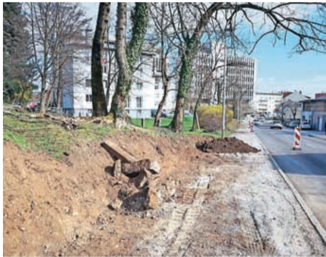
Gradnja kolesarske poti na Koroški cesti
