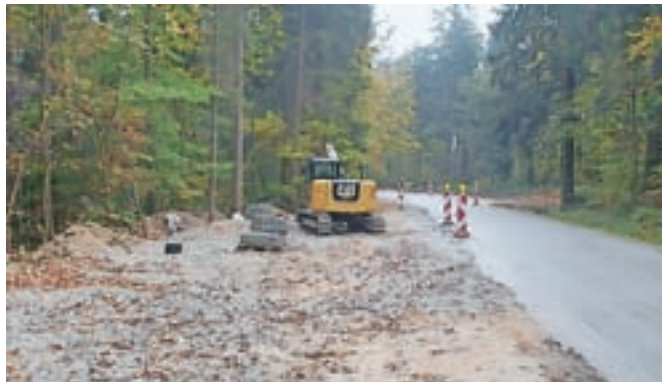
Gradnja parkirišč je v zaključni fazi.
