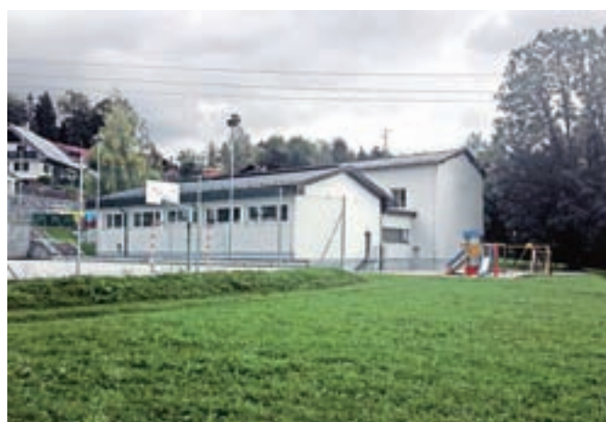
Podružnična šola na Trsteniku je prenovljena.
