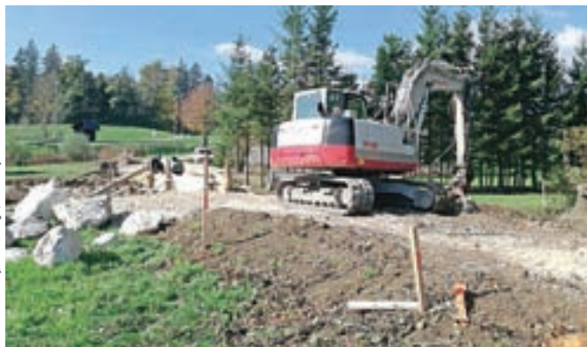
Gradnja pločnika Goriče–Golnik poteka po načrtu.
