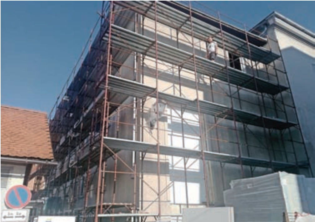
Energetske sanacije stavb v Kranju so se že začele.
