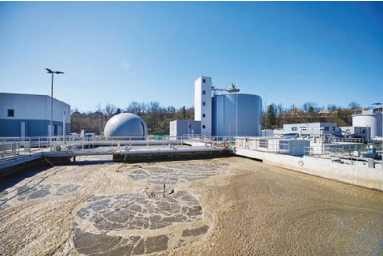
Centralna čistilna naprava Kranj / Foto: Samo Paušer
