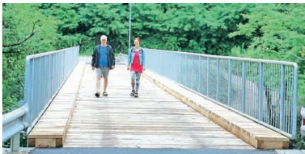
Prenovljen most je od prejšnjega tedna spet odprt. / FOTO: TINA DOKL
