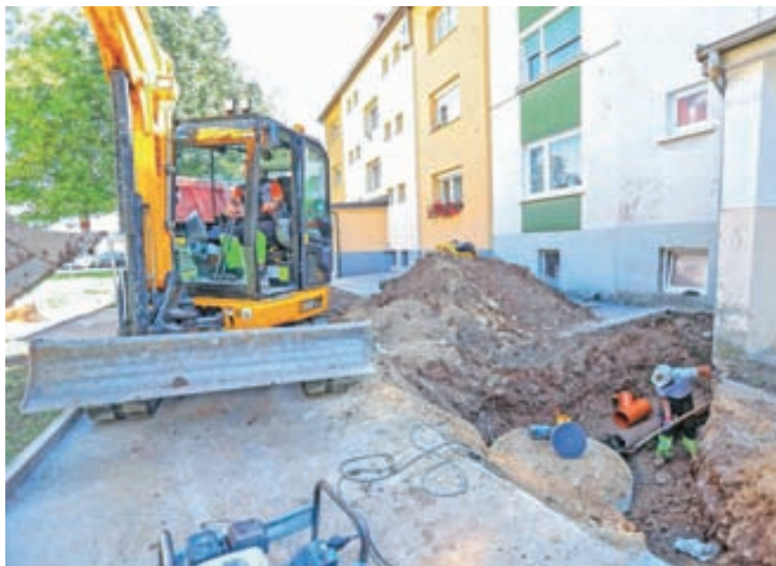
Komunalno infrastrukturo obnavljajo tudi na delu Planine, dela bodo predvidoma zaključena do poletja 2021. / Foto: Tina Dokl
