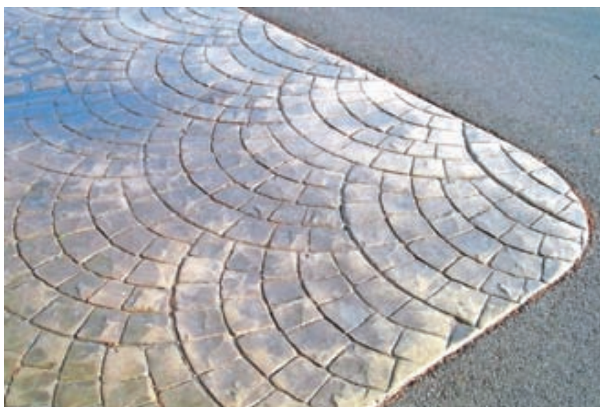
Fuge so betonske in omogočajo izpiranje z vodo.
