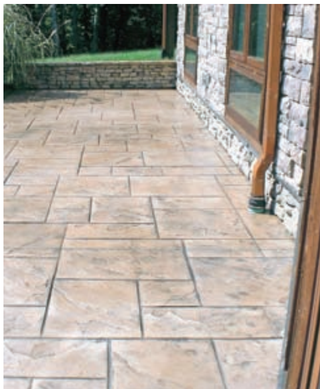
Čiščenje trave in drugega plevela iz fug je pri tiskanem betonu preteklost.
