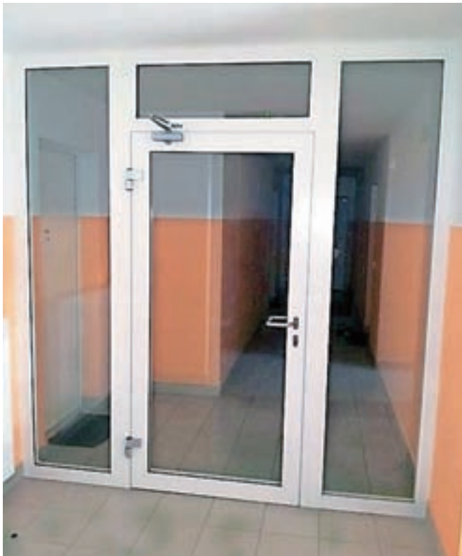
Primer steklenih protipožarnih vrat. Na prvi pogled so povsem običajna vrata.
