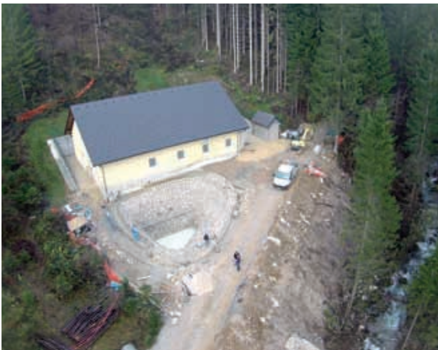
Objekt ultrafiltracije Bašelj je pripravljen na tehnični pregled.
