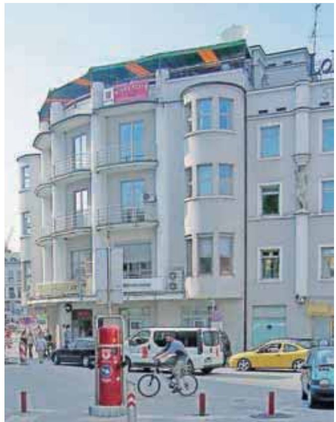
Stara pošta že ima svojo energetska izkaznico.
