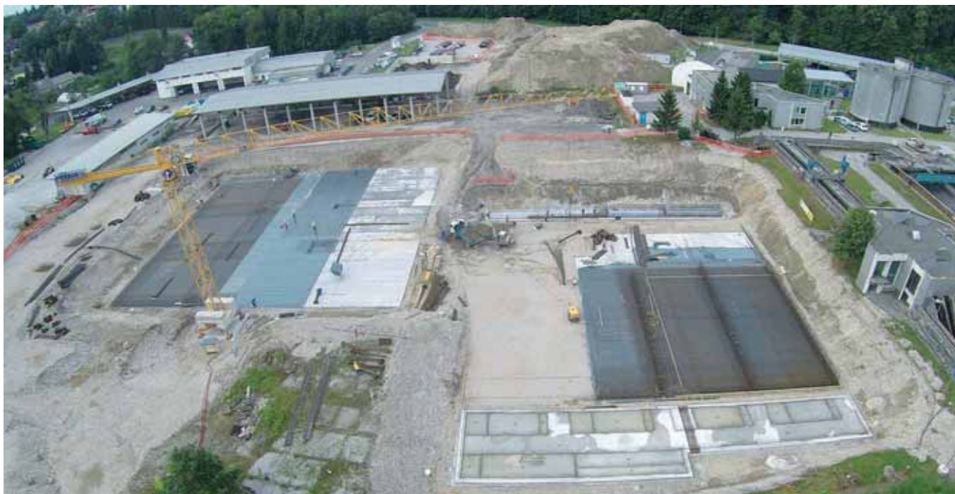
Pogled na gradnjo Centralne čistilne naprave Kranj iz zraka: izvedeni so izkopi in poglobitve ter sanacija temeljnih tal na dveh največjih objektih, izvajajo se opaži in armatura sten poglobljenega zahodnega dela objekta, izvedena je glavna podložnih betonov.
