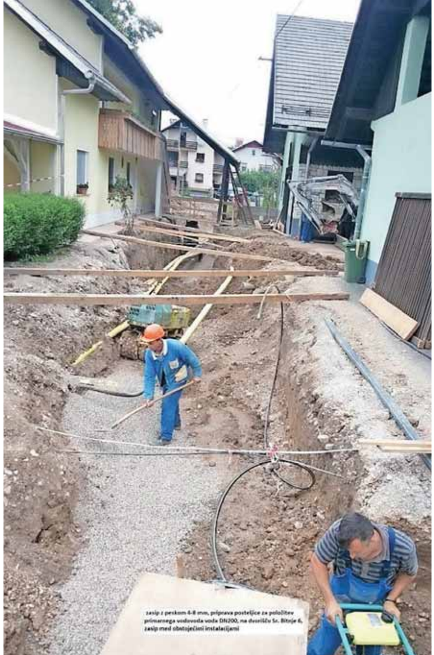
Izvedba kanala pred hišo v Srednjih Bitnjah 6
