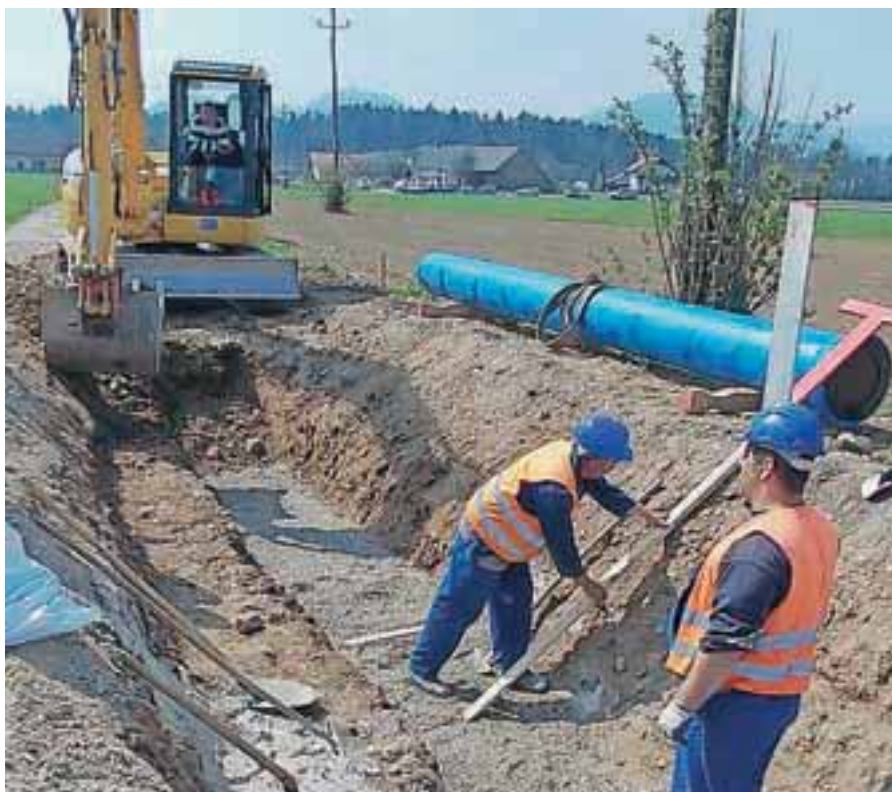
Vgradnja in zasip vodovodnih cevi na odseku Ilovka-Brdo
