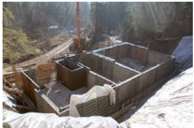
Gradnja ultrafiltracije Bašelj
