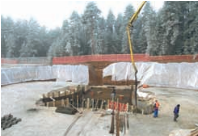
Gradnja vodohrana Zeleni hrib
