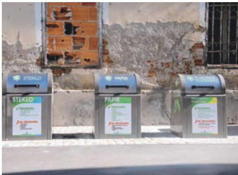
Podzemni zabojniki za ločeno zbiranje odpadkov na Gasilskem trgu
