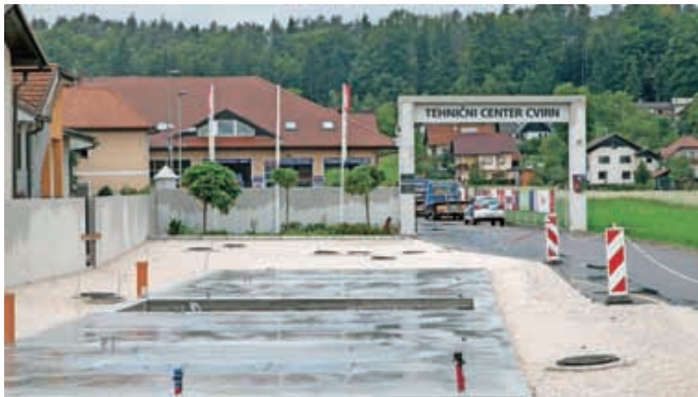
Temelji za avtopralnico v Podgorju so že pripravljeni. / FOTO: ALEŠ SENOŽETNIK
