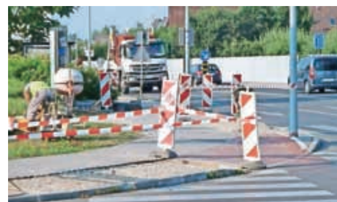
Prenova odsekov Ljubljanske ceste je že končana.
