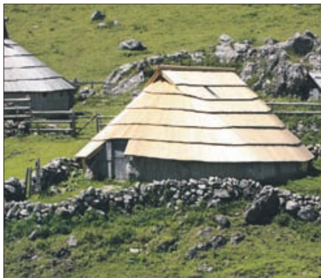
Preskarjeva pastirska bajta se to poletje od ostalih loči tudi po povsem novi kritini iz smrekovih skodel. | FOTO: JASNA PALADIN
