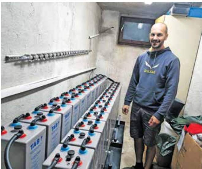
Oskrbnik kočice na Kamniškem sedlu Iztok Kolenc ob novih baterijah za shranjevanje energije, ki jo pridobivajo s sončnimi celicami na strehi kočice / FOTO: JASNA PALADIN
