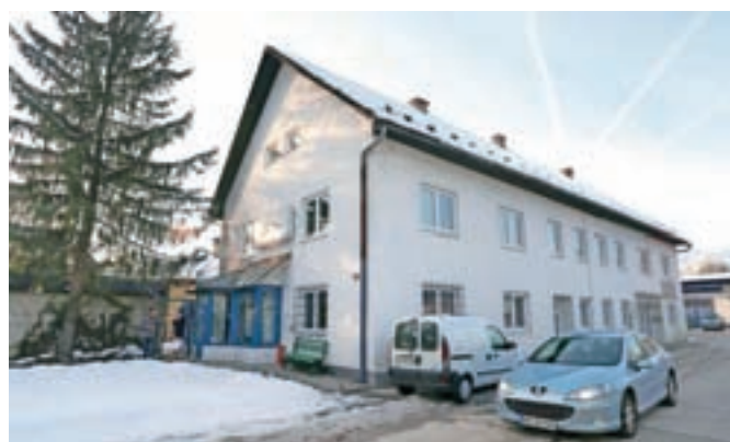
Stavba KIKštarterja je od lanskega leta naprodaj, za njen nakup in obnovo nameravajo podjetniki sami zbrati 120 tisoč evrov. / FOTO: GORAZD KAVČIČ
