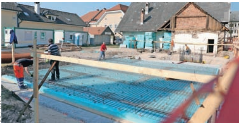
Pri Blagneči hiši so začeli marca graditi prostore, v katerih bo medgeneracijski center.
