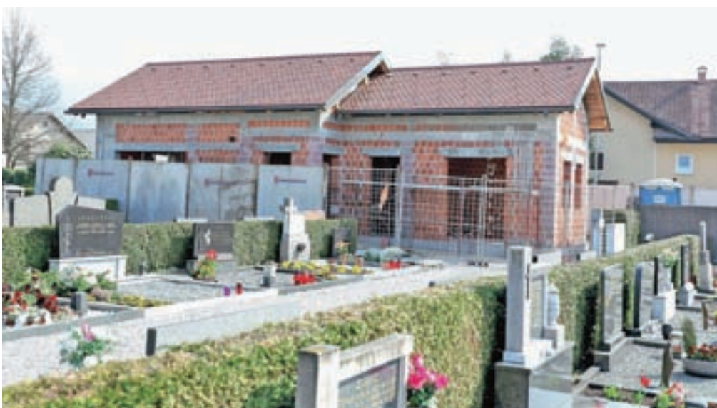
Gradnja stavbe ob pokopališču je v polnem teku, urejajo tudi del pokopališča, namenjenega raztrosu pepela. / FOTO: TINA DOKL
