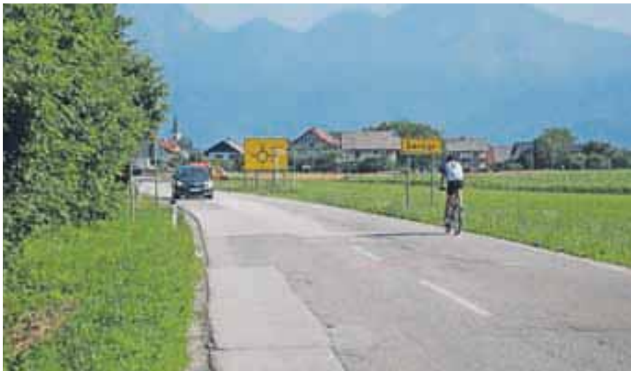
Na cesti Šenčur–Voklo bodo prihodnji teden zarohneli gradbeni stroji.
