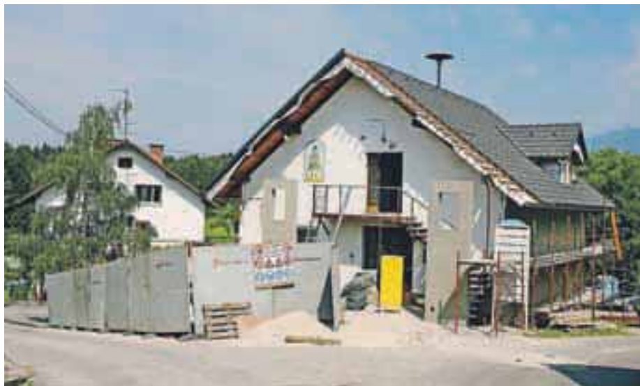
Gradbena dela na vaškem in gasilskem domu Hotemaže so v polnem razmahu.
