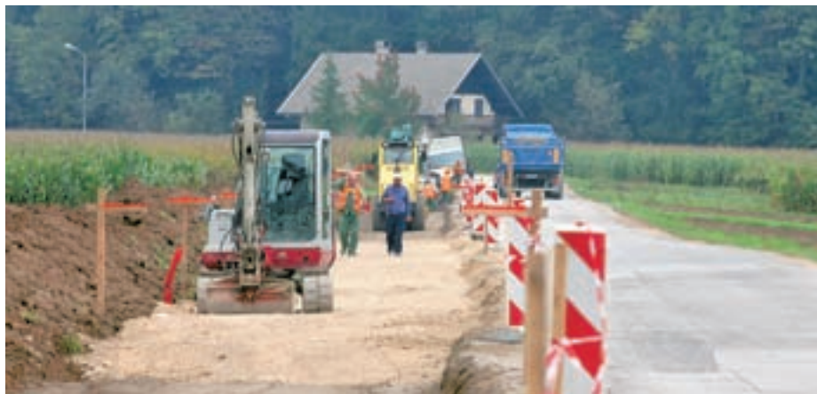
Začetek rekonstrukcije ceste Voklo-Prebačevo
