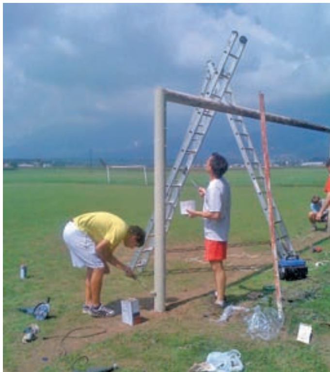
Nogometno igrišče na Olševku - Storžice - so obnovili s prostovoljnimi delom.
