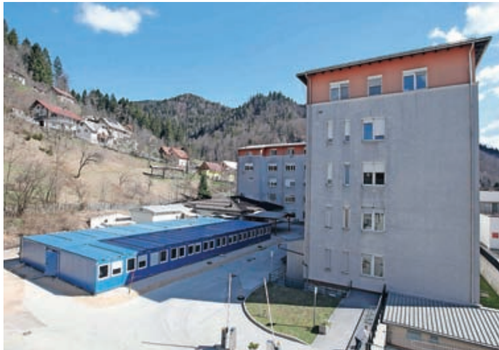
Bivalni zabojniki ob Splošni bolnišnici Jesenice: v njih so pridobili dodatnih 23 postelj, vanje bodo v času energetske in požarne sanacije preselili negovalni oddelek. / FOTO: GORAZD KAVČIČ
