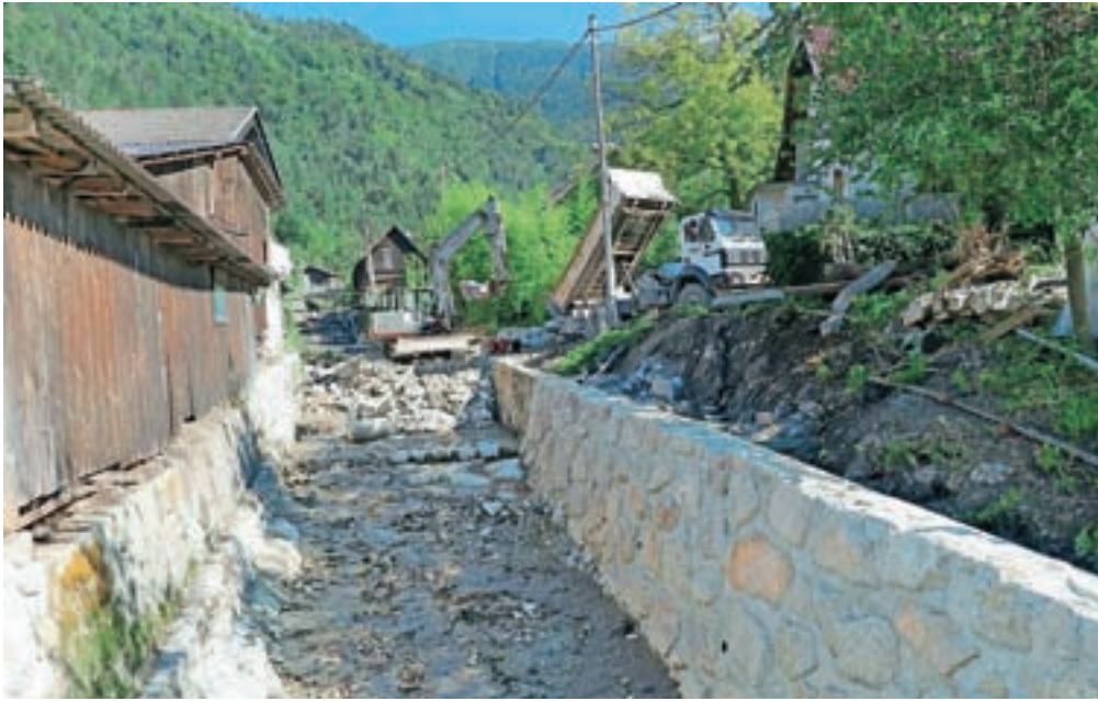
Dela v strugi potoka na Koroški Beli, ki jih izvaja VGP Kranj, potekajo še hitreje od načrtov.
