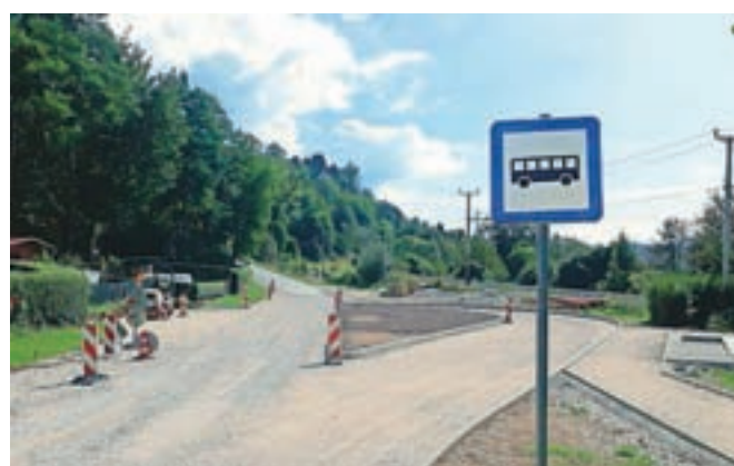
Obračališče za avtobuse na Tomšičevi že dobiva končno podobo.
