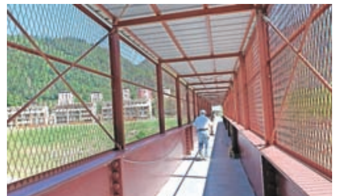
"Rdeči" most na Hrenovci je dobil novo pohodno površino in nadstrešnico.
