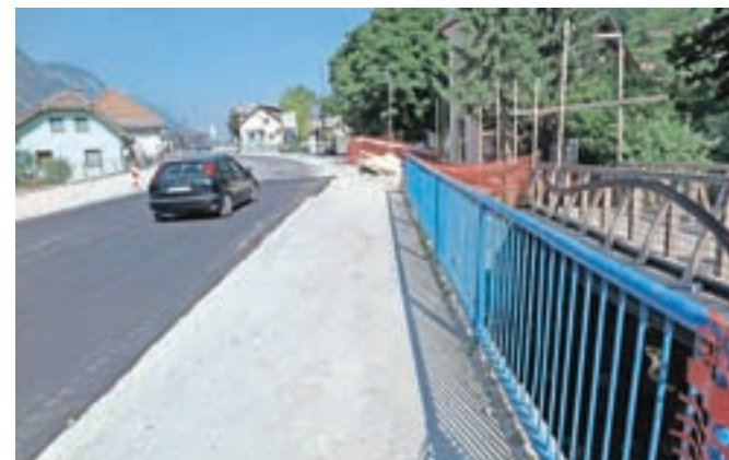
Obnova ceste naj bi bila dokončana do konca leta.
