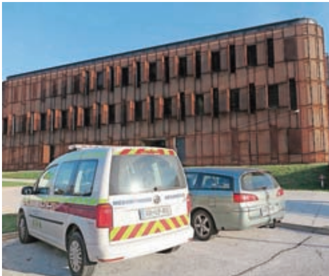
MIR Jesenice po novem deluje v stavbi Upravnega centra Jesenice.
