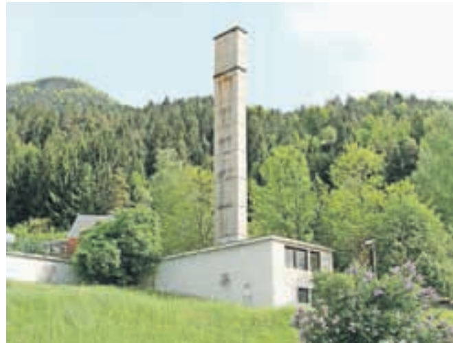
Kotlovnica na Belem polju, ki jo bodo temeljito prenovili.
