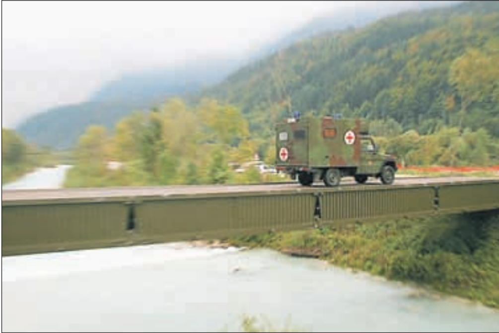
Pripadniki 14. inženirskega bataljona so pri Hrušici postavili lansirni most Eurobridge, ki se ponaša z nosilnostjo več kot štirideset ton, postavijo pa ga lahko v štirih urah.
