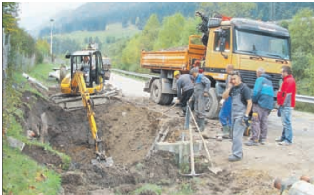
Popravilo vodovoda Peričnik
