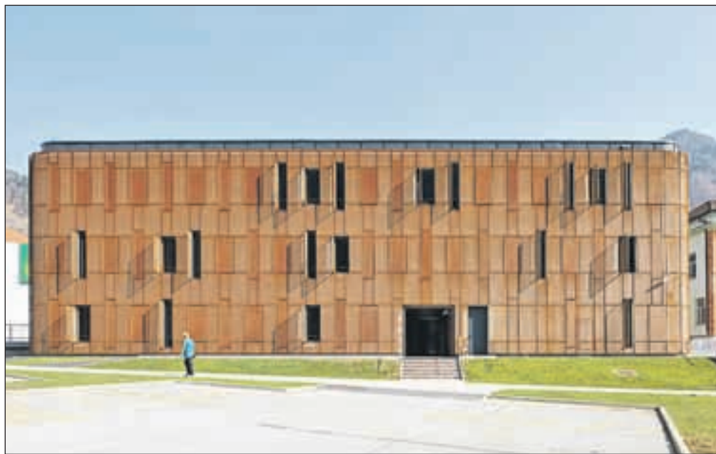
Nova stavba Upravne enote Jesenice na Jesenicah. Njena zunanost, izdelana iz kortenskih plošč, ki simbolizira železarsko tradicijo Jesenic, pa med ljudmi zbuja mešane občutke.
