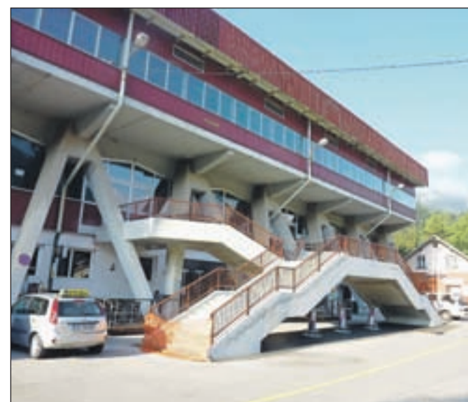
Novo zunanje stopnišče pri dvorani Podmežakla
