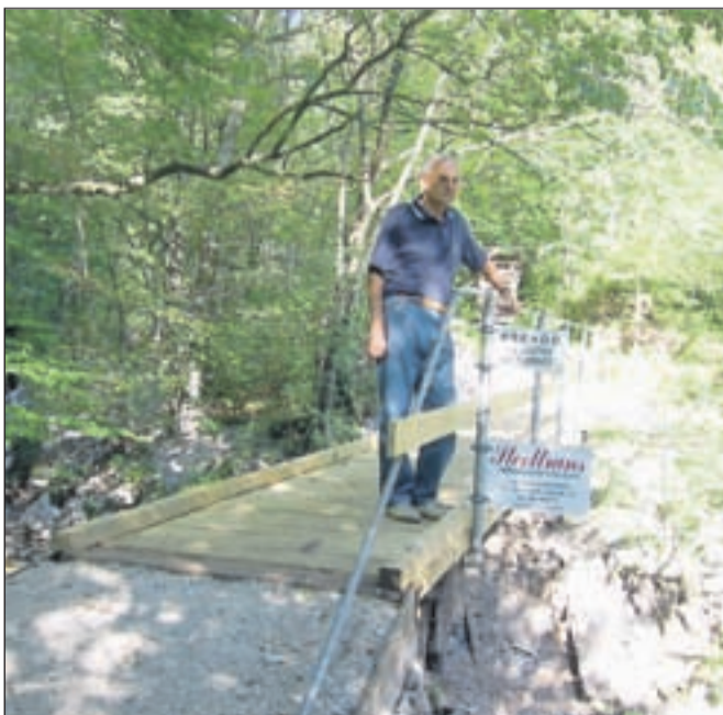
Jernej Udir na novem mostu čez potok Bela v Zevnikih
