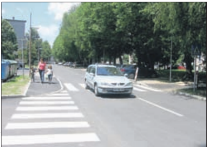
Končuje se druga faza obnove Tavčarjeve ceste.
