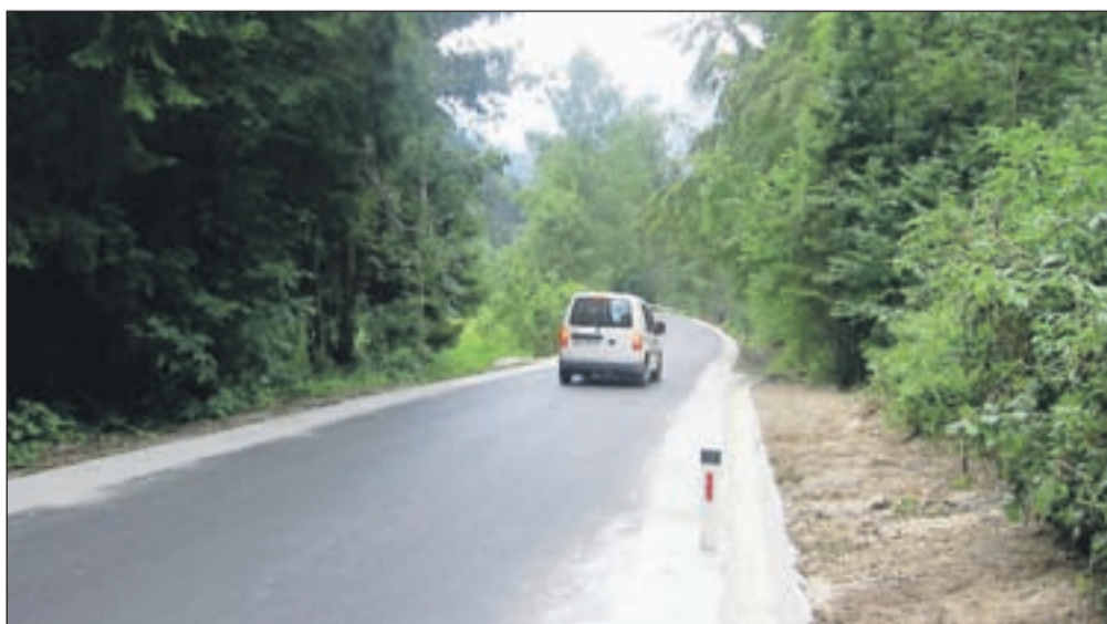
Obnovljena cesta v Javorniški Rovt
