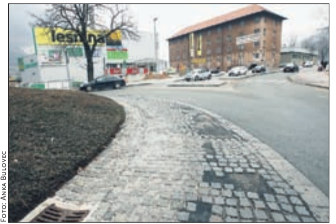
Granitne kocke odpadajo s cestišča v krožišču.
