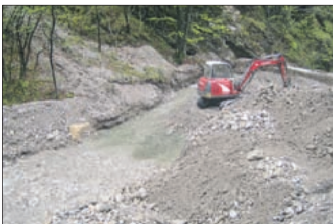
Strugo potoka Bela so na dveh delih začeli urejati konec aprila.
