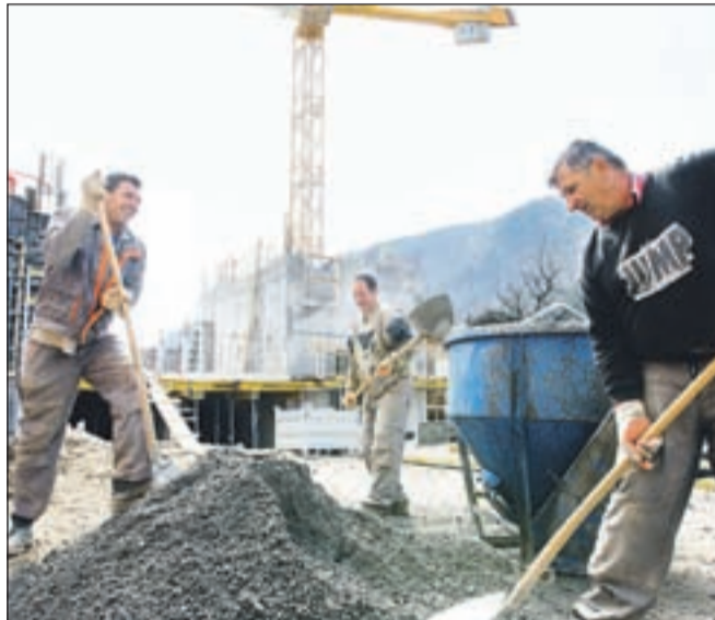
Kovinar Gradnje ST je tudi izvajalec gradnje parkirne hiše pri Splošni bolnišnici Jesenice. | FOTO: ANKA BULOVEC
