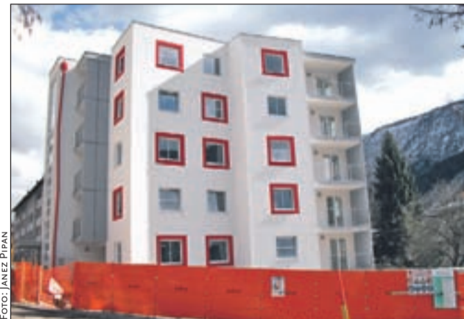
Blok z oskrbovanimi stanovanji na Bokalovi ulici
