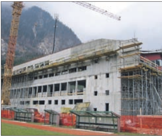
Obnova Hale Podmežakla
