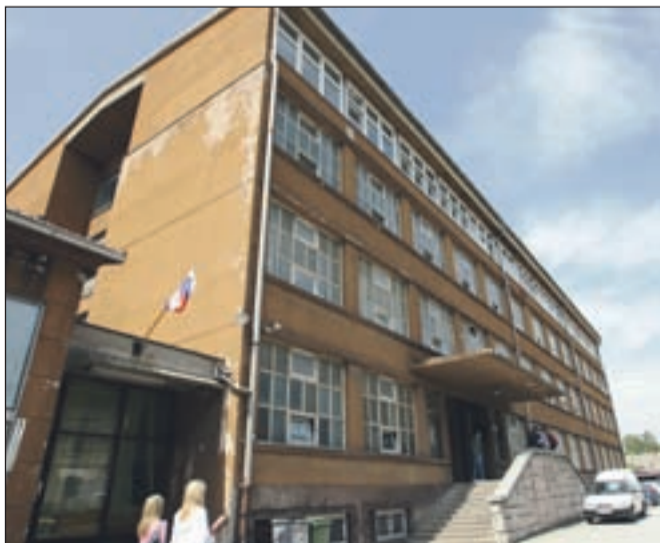
Da je obnova stavbe Srednje šole Jesenice nujna, se na Jesenicah zavedajo že vrsto let. | FOTO: ANKA BULOVEC
