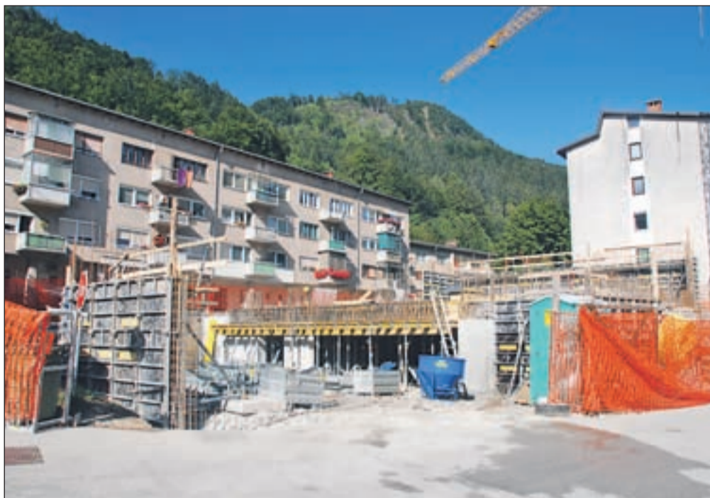
Blok z oskrbovanimi stanovanji naj bi bil zgrajen do pomladi prihodnje leto. Objekt bo imel pritličje in še štiri etaže, v kleti pa bodo garaže. | FOTO: JANEZ PIPAN
