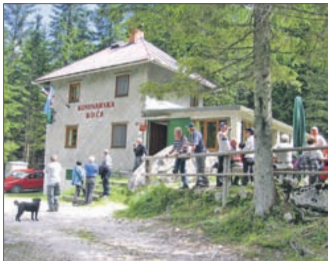
Kovinarska kočica v Krmi - v načrtu imajo razširitev jedilnice ter obnovo fasade in strehe.
