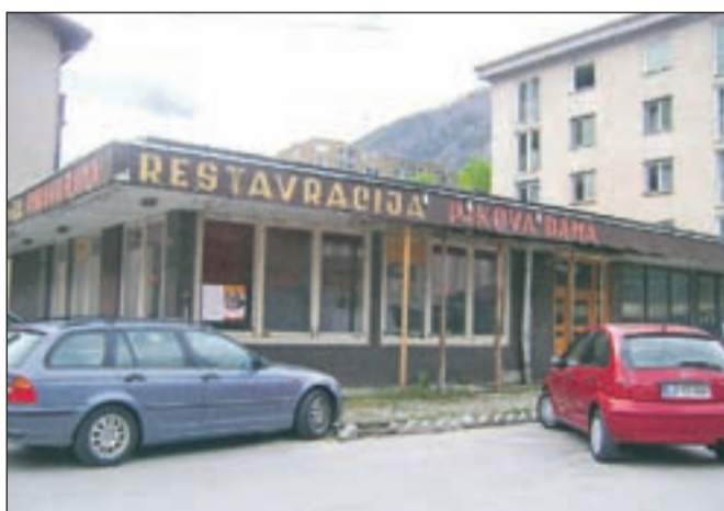
Blok na Tavčarjevi 4 je od Pikove dame oddaljen le 2,76 metra. Nadzidava Pikove dame bi jim, kot trdijo stanovalci, povsem zakrila svetlobo.
