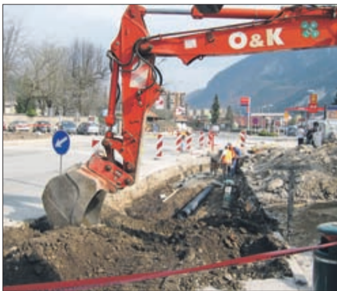
Gradbena dela pri bolnišnici | FOTO: JANEZ PIPAN
