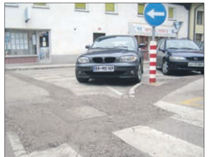
Podjetje, ki je gradilo optično omrežje, dela ni opravilo do konca.
