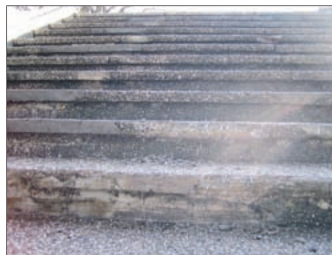
Stopnice na pokopališču so potrebne le manjših popravil.
