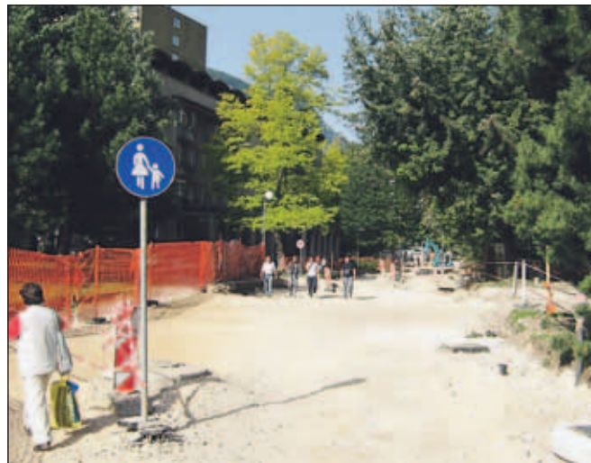
Obnova Tavčarjeve ulice bo zaključena oktobra. | FOTO: JANEZ PIPAN
