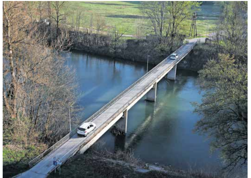
Gradbeno dovoljenje za gradnjo novega mostu pri Planiki, ki bo zamenjal obstoječi most (na sliki), je postalo pravnomočno. / Foto: Gorazd Kavčič
