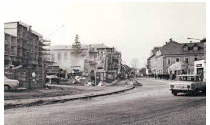
Rušenje Majdičeve hiše in gradnja Hotela Creina leta 1967. Na desni strani ceste še stojita Gorjančeva hiša in stavba tiskarne. / Foto: Cene Avguštin, fototeka Gorenjskega muzeja
