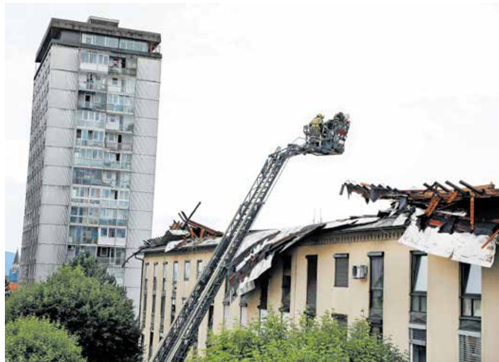
S stavbe Kantarček v Kranju je veter streho odnesel v nekaj sekundah. / Foto: Tina Dokl
