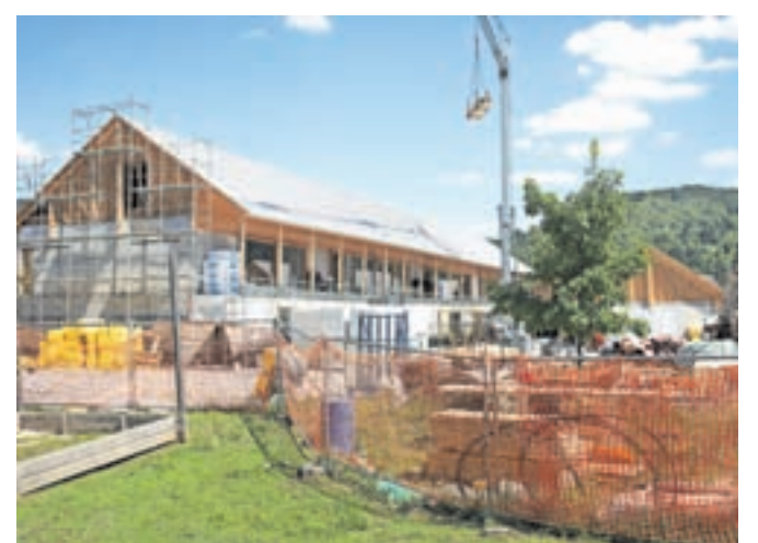
Stavbe novega vrtca v Bohinjski Bistrici že stojijo, zdaj glavina del poteka v notranjosti. / Foto: Gorazd Kavčič
