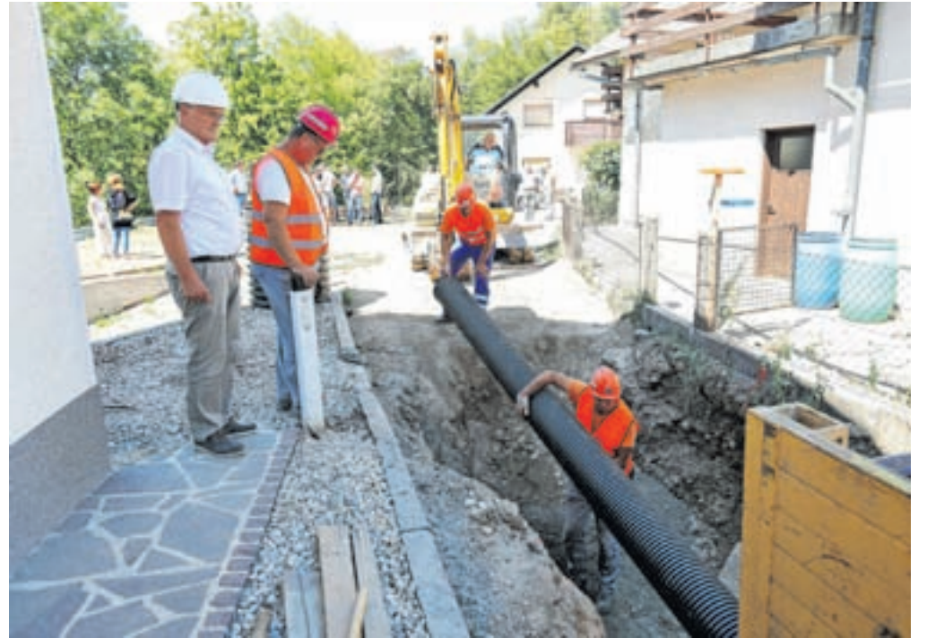
Na Prebačevem so položili zadnjo cev javnega kanalizacijskega sistema v občini Šenčur.
