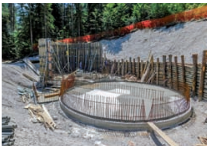
Novi vodohran Alpina v Kranjski Gori zmogljivosti šeststo kubičnih metrov naj bi bil zgrajen do konca letošnjega leta. / Foto: Arhiv Občine
