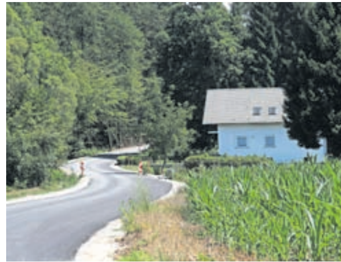
Obnova ceste čez Gorajte / Foto: Gorazd Kavčič
