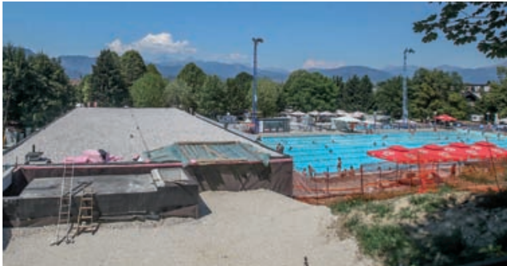
Bazen je ločen od gradbišča, obiskovalci kopališča in kampa že lahko uporabljajo nove sanitarije. / Foto: Gorazd Kavčič
